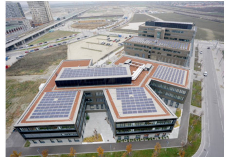
Abbildung 13: PV-Dachanlage auf dem Technologiezentrum 2 in der Seestadt Aspern
