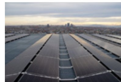
Verschattungselement Nachträglich aufgebracht Transparente PV
