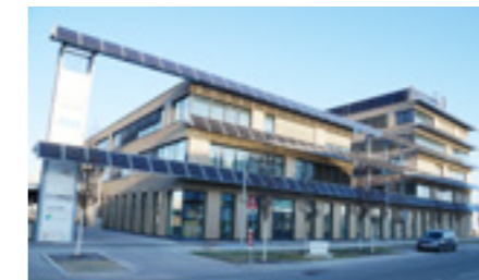
Abbildung 27: PV-Module an der Fassade des Technologiezentrums 1 in der Seestadt Aspern dienen als Vordach
