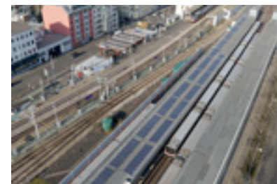
Nachträglich installierte PV-Anlagen
