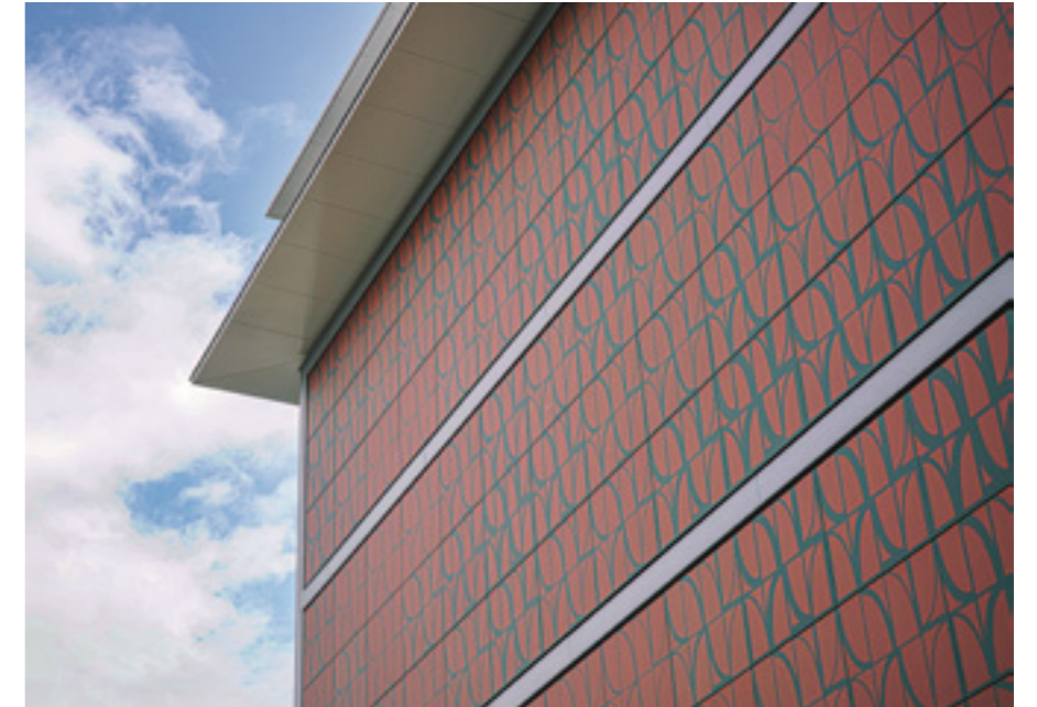
Abbildung 21: Energiehaus Luzern mit bedruckter Fassade, die Strom erzeugt
