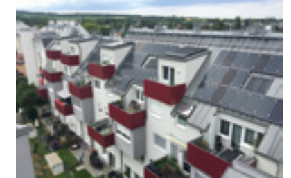
PV auf Mehrparteiengebäude
