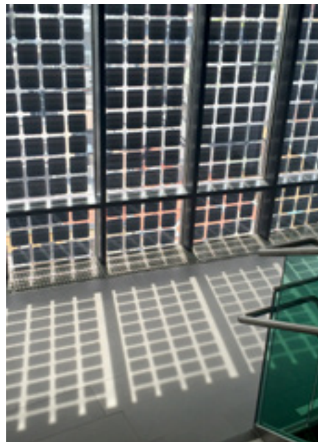
Gebäudeintegrierte PV Transparente PV Fassaden-PV
