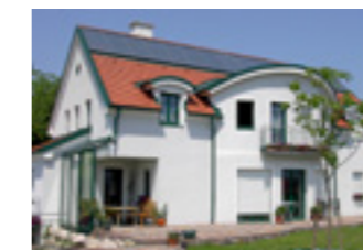
Abbildung 37: Indachkollektoren auf Einfamilienhaus
