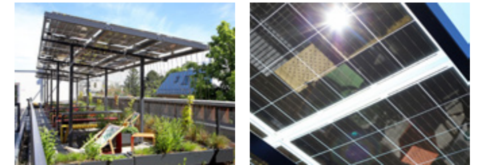
Abbildung 58 + 59: PV-Dachgarten am neuen TUVI-Gebäude der Universität für Bodenkultur Wien
